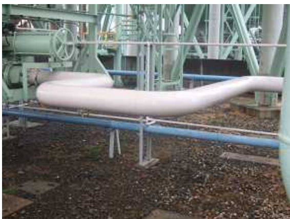
タンク周り配管の耐震化
