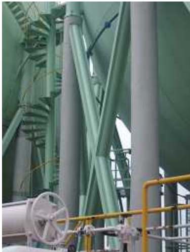
脚柱間斜鋼の補強
