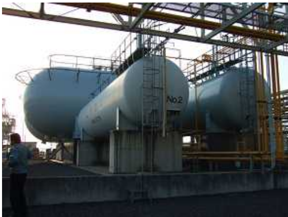
L P ガス貯槽 (手前 50 t タンク、奥 400 t タンク) 容器置き場
