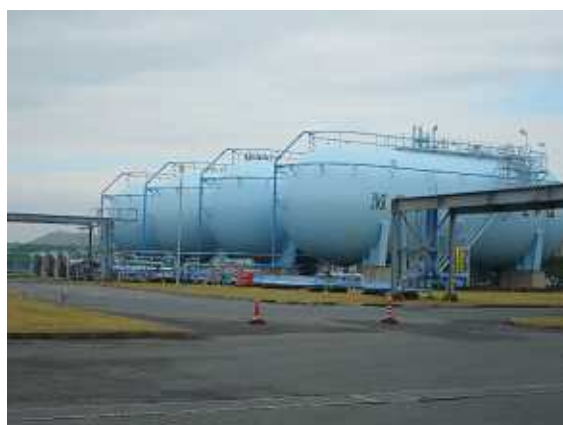
国内最大の900t級大型LPG貯槽
