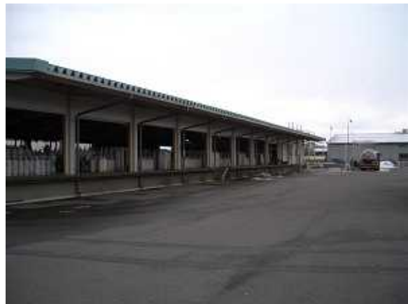
充てんプラットフォーム外観
