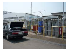
3: オートガス/DME 混合容器と専用スタンド設備
