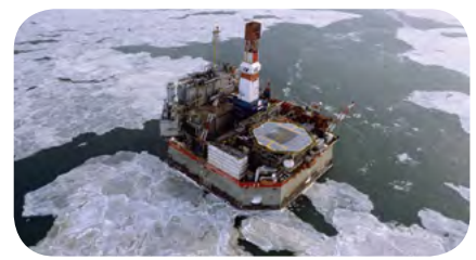
洋上ガス田(ロシア・サハリン)
