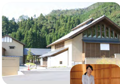
京都府伊根町:伊根町コミュニティセンター「ほっと館」
