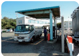
LPガス自動車充填設備
