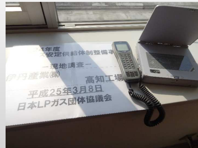
非常用衛星通信電話
