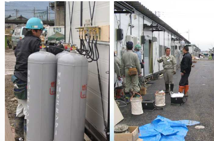
仮設住宅にガス設備を設置
