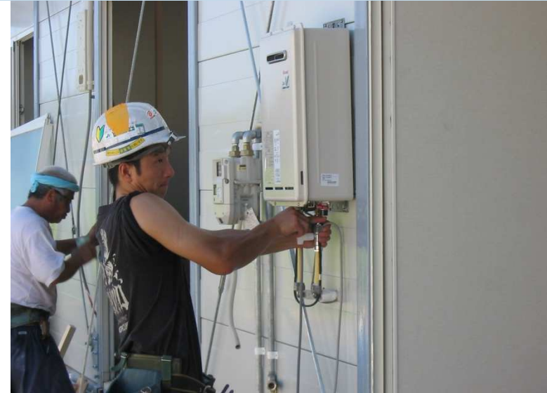
仮設住宅への給湯機の設置
