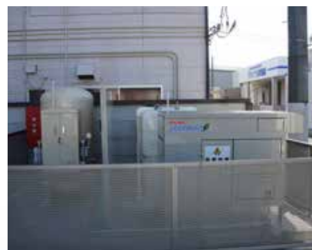
災害バルク貯槽と非常用発電機
