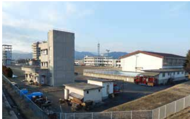
長野県消防学校
