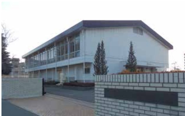
避難所に指定されている屋内訓練場
