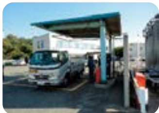
LP自動車充填設備
