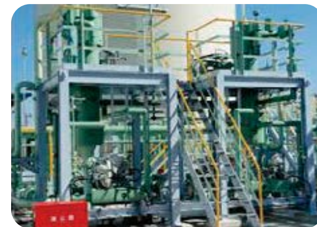
熱量調整装置(出典:九州ガス圧送 株)
